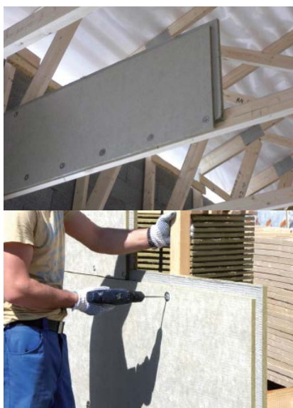
FireSAFE PR30 levyn kiinnitys puuruuveilla ja aluslevyillä kattokannattajaan. Levyjen asennus on helppoa ja sujuvaa ruuviväänintä käyttämällä.
