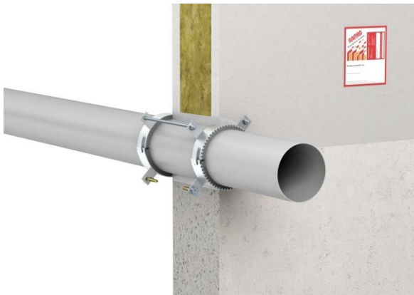
Kuva seinä asennuksesta
