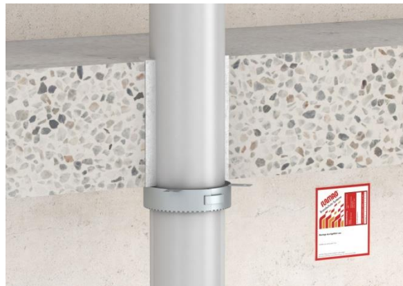
Kuva katto asennuksesta
